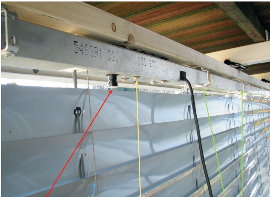
Druckabschaltung oben Leiterband Motorverschraubung Träger (Konsolen)
