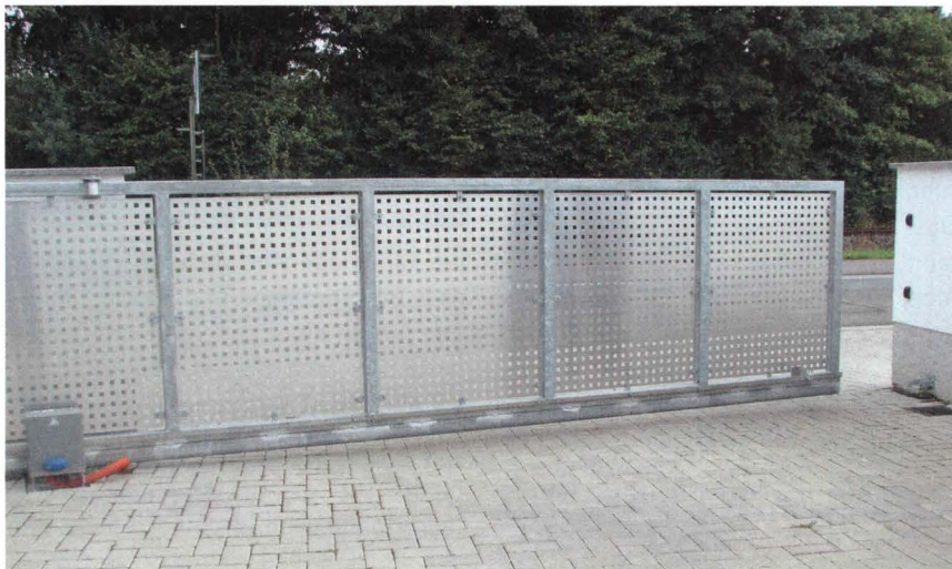
Dieses Schiebetor fertigte der ausführende Betrieb, ohne die technischen Regeln zu beachten.
