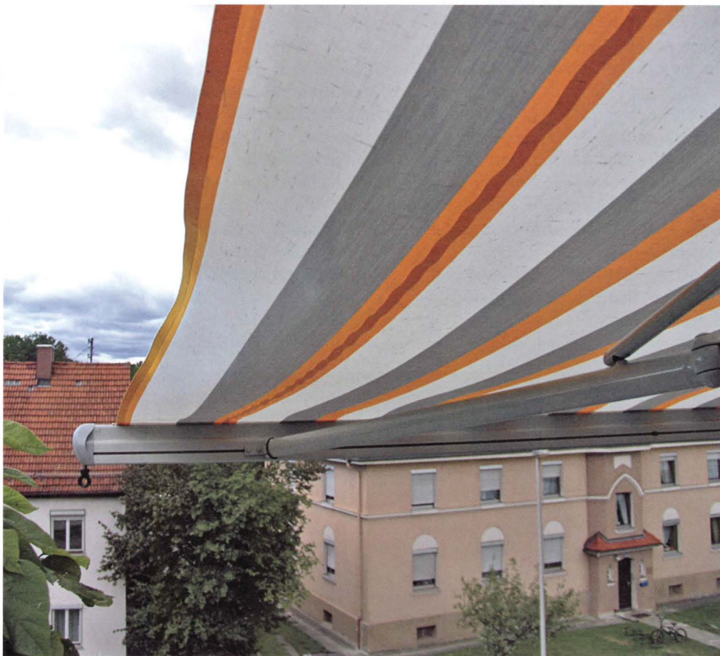
So stellt sich die Außenflanke dar, wenn die Konstruktion Witterungseinflüssen ausgesetzt ist und an Stabilität verloren hat.
